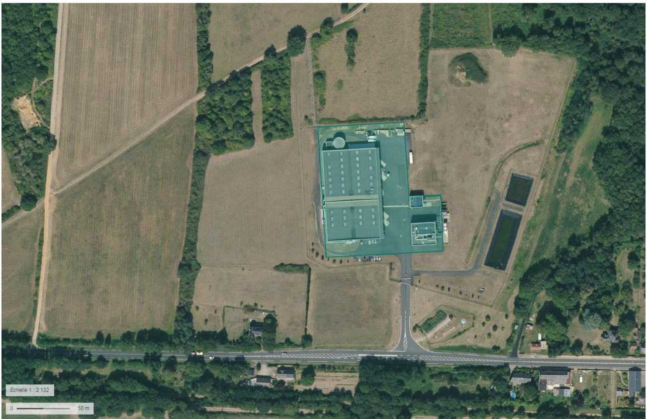
Figure 8 : Environnement de la STEARINERIE DUBOIS
